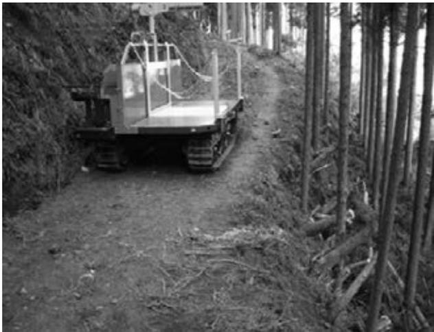
図5 林内路網(上は「作業道」幅員約3m, 下は「作業路」幅員約2m)
